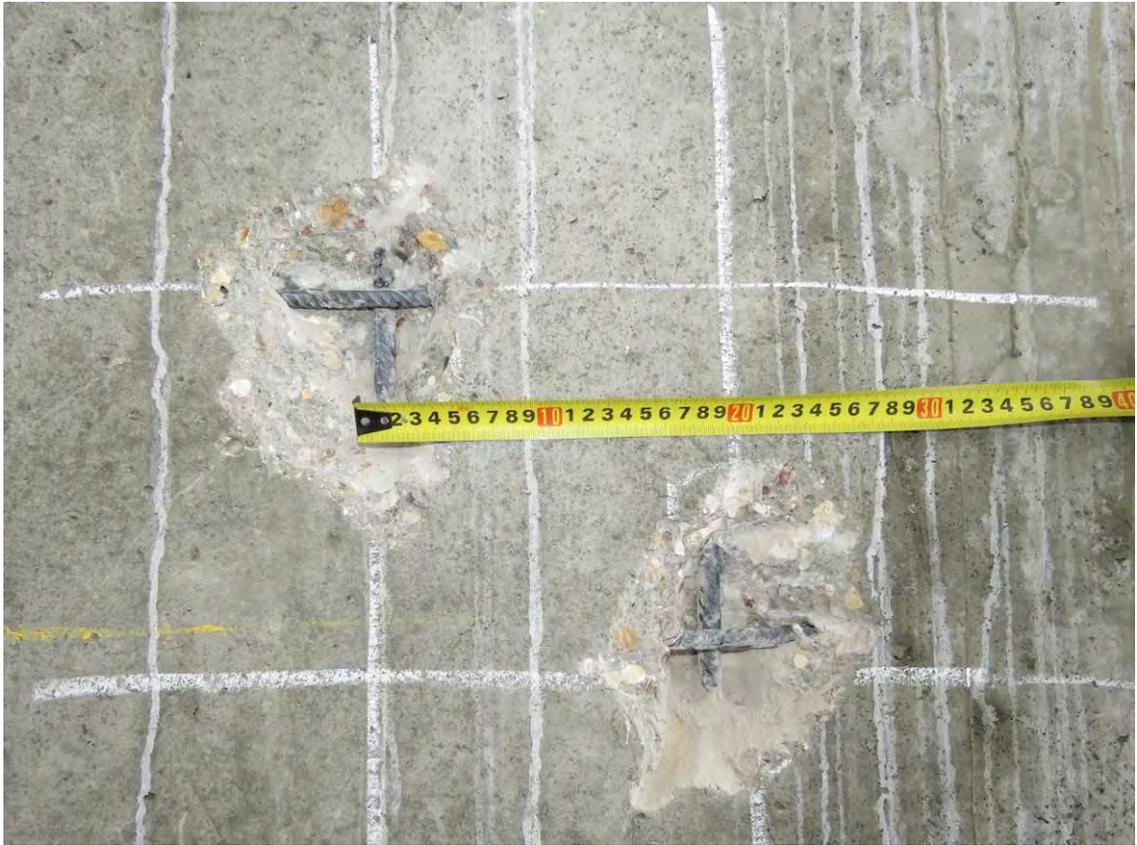
Рис. 3.2.3. Замер шага вертикального армирования пилона на отм.  $\pm 0,000$  м на пересечении осей 12с3, Ас4
