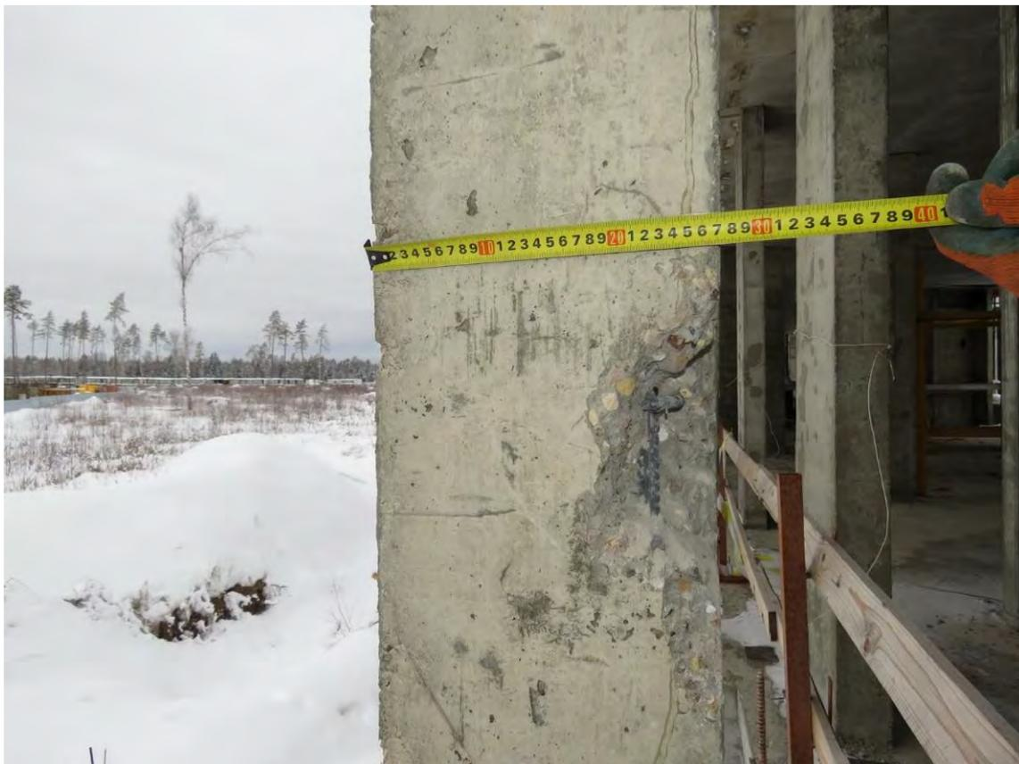
**Рис. 3.2.1. Замер сечения монолитной ж.б. колонны на отм.  $\pm 0,000$  м между осями Бс3-Вс3**
