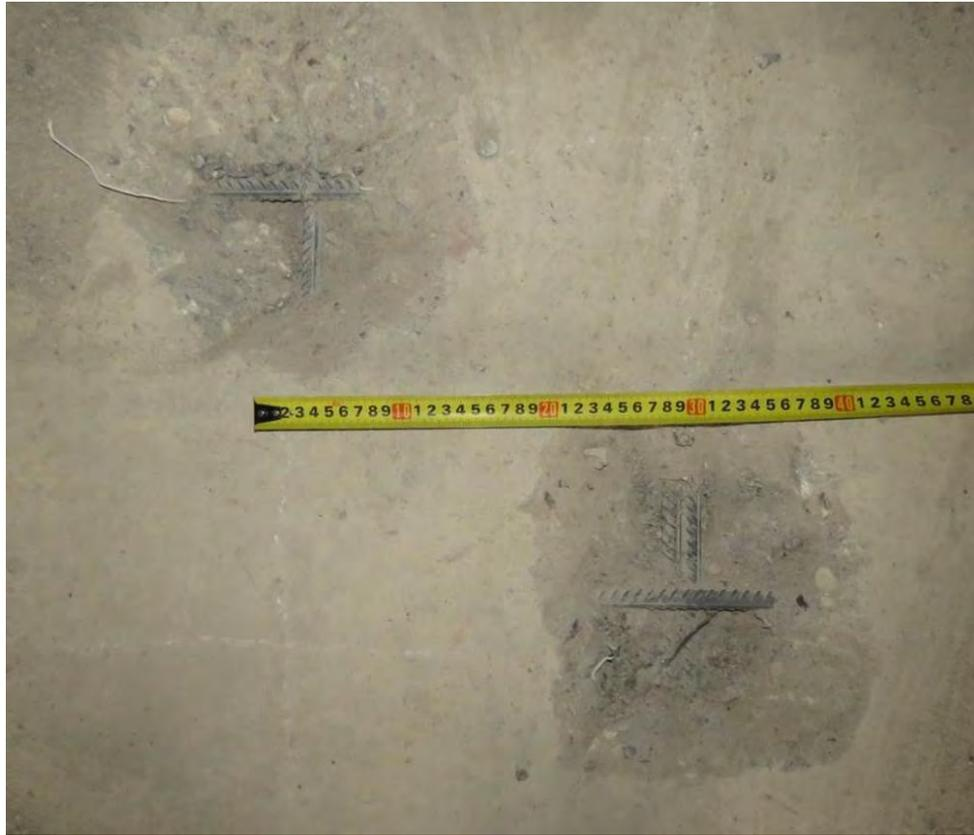
**Рис. 3.1.5. Замер шага (250 мм) вдоль цифровых осей верхней зоны армирования фундаментной плиты секции 3 между осями 13с3-14с3, Бс3-Вс3**
