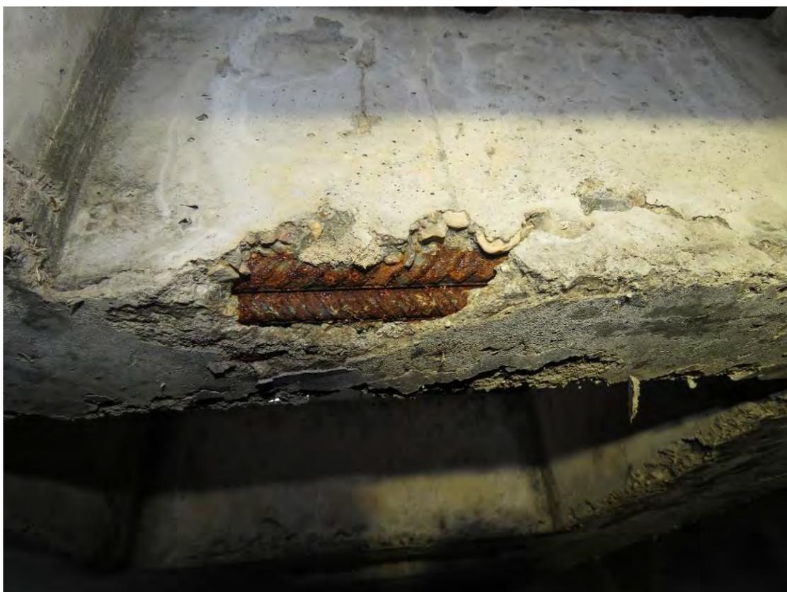
**Рис. 3.3.10. Скол бетона с оголением арматуры и поражением ее коррозией в плите перекрытия подвала в зоне проема между осями Кс2-Лс2 и 3с1-4с1**
