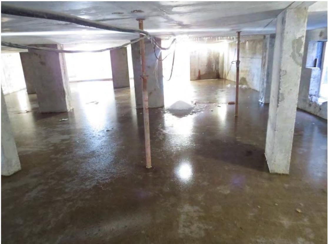
**Рис. 3.1.12. Замачивание верхней поверхности фундаментной плиты с последующим замерзанием и фазового перехода воды в лед на высоту до 50 мм**
