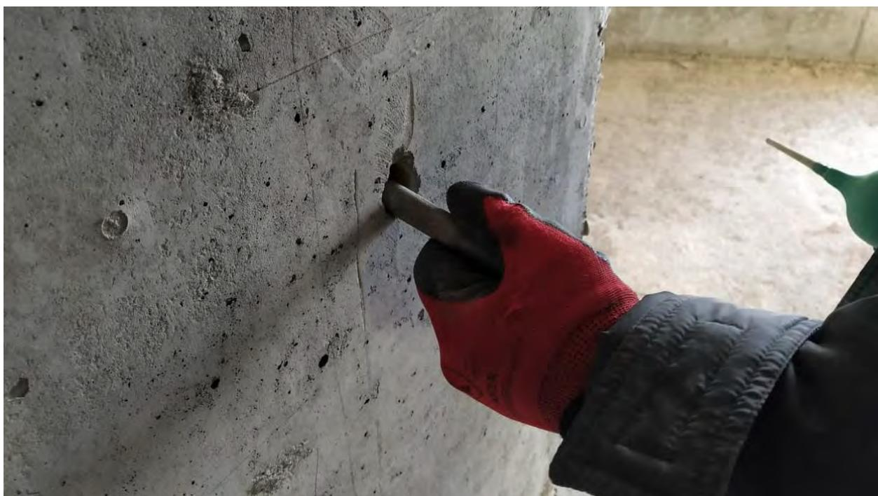
**Рис. 4.2.1. Прочистка отверстия в монолитном железобетонном пилоне в осях 6с2-7с2/Вс2**
