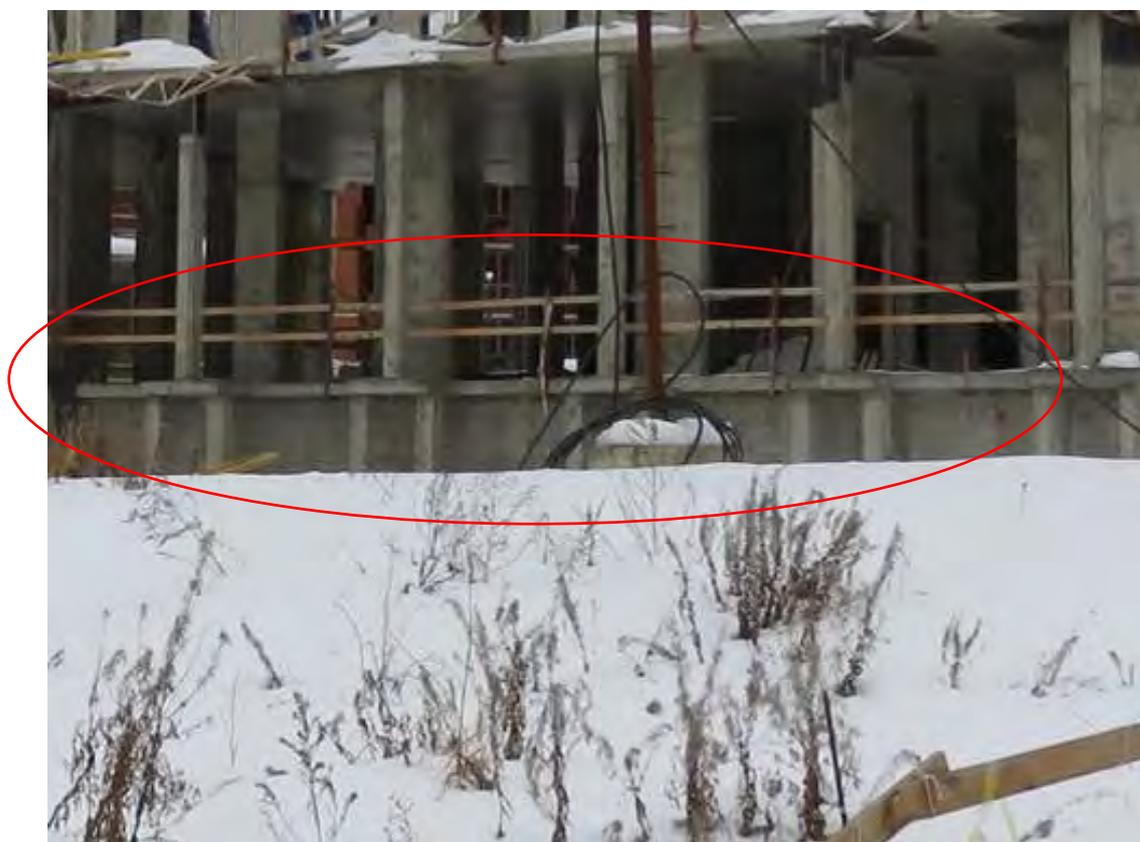
**Рис. 3.2.10. Непроектное расположение монолитных ж.б. колонн на секции 1, 2 и 3 на отм. ±0,000 м**
