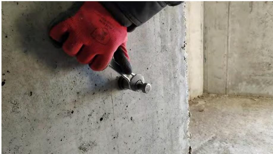
**Рис. 4.2.3. Установка анкерного устройства и тяги в отверстии монолитного железобетонного пилона в осях бс2-7с2/Вс2**
