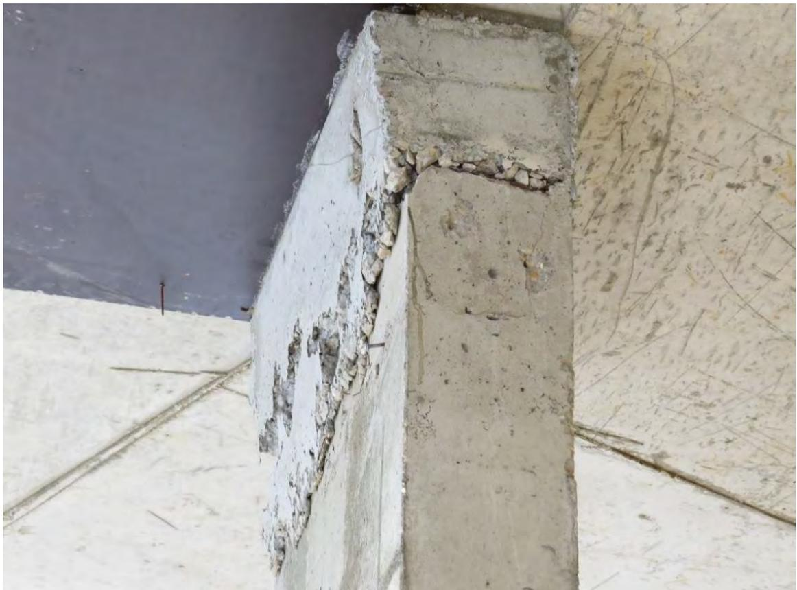
**Рис. 3.2.8. Непроектное сечение оголовка пилона секции 1 и 2 на отм. ±0,000 м**
