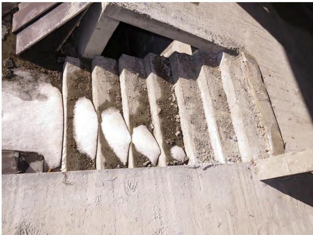
**Рис. 3.5.2. Общий вид лестничной клетки (одномаршевой монолитной железобетонной лестницы) расположенной в уровне первого этажа секции 4 расположенной между осями 4с4-5с4 и Бс4-Вс4**
