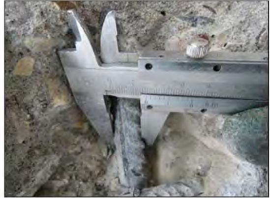
ФОТО 14. Уточнение диаметра рабочей арматуры монолитного ж/б пилона 1-го этажа расположенного на пересечении осей «Ес3» и «5с3».
