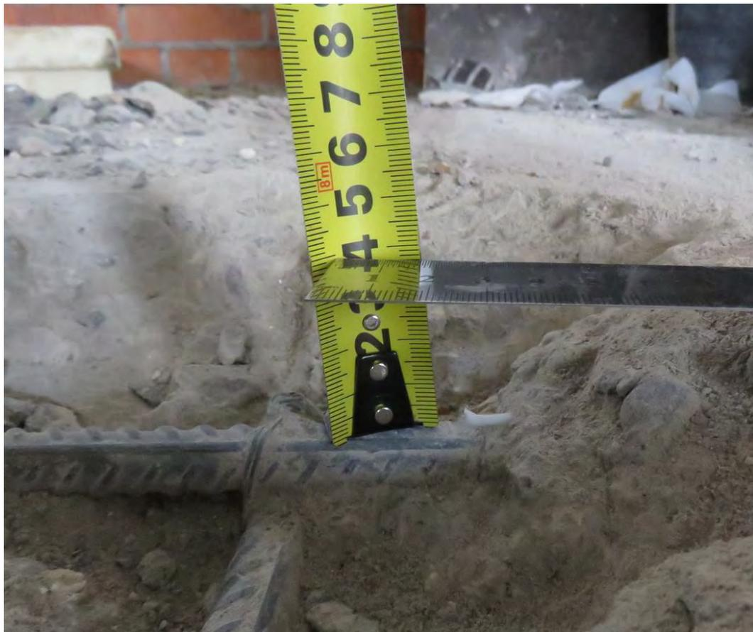
**Рис. 3.1.8. Определение толщины (37 мм) защитного слоя бетона верхнего армирования фундаментной плиты секции 3 между осями 13с3-14с3, Бс3-Вс3**
