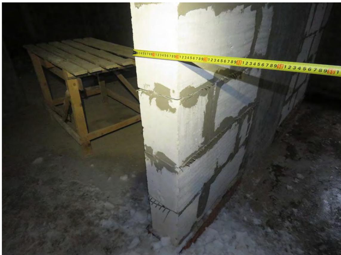
**Рис. 3.5.2. Замер толщины внутренней перегородки в подвальном этаже жилого дома секции №5**
