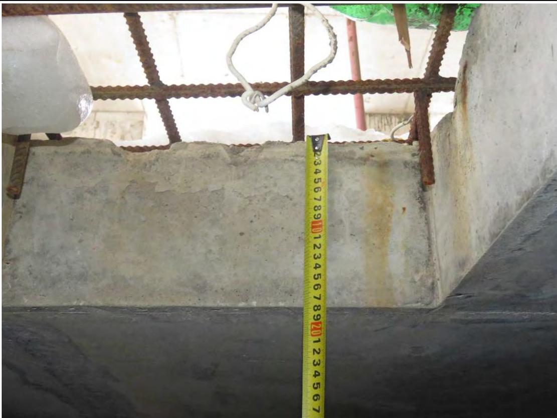
**Рис. 3.3.3. Замер толщины монолитной ж.б. плиты перекрытия**
