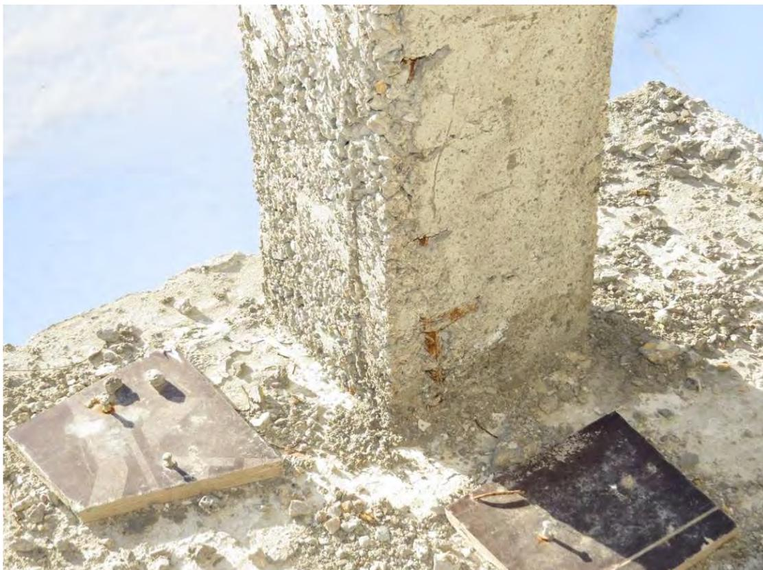
**Рис. 3.2.9. Непровебрированный бетон и отсутствие защитного слоя бетона монолитных ж.б. колонн секции 1 на отм. ±0,000 м**
