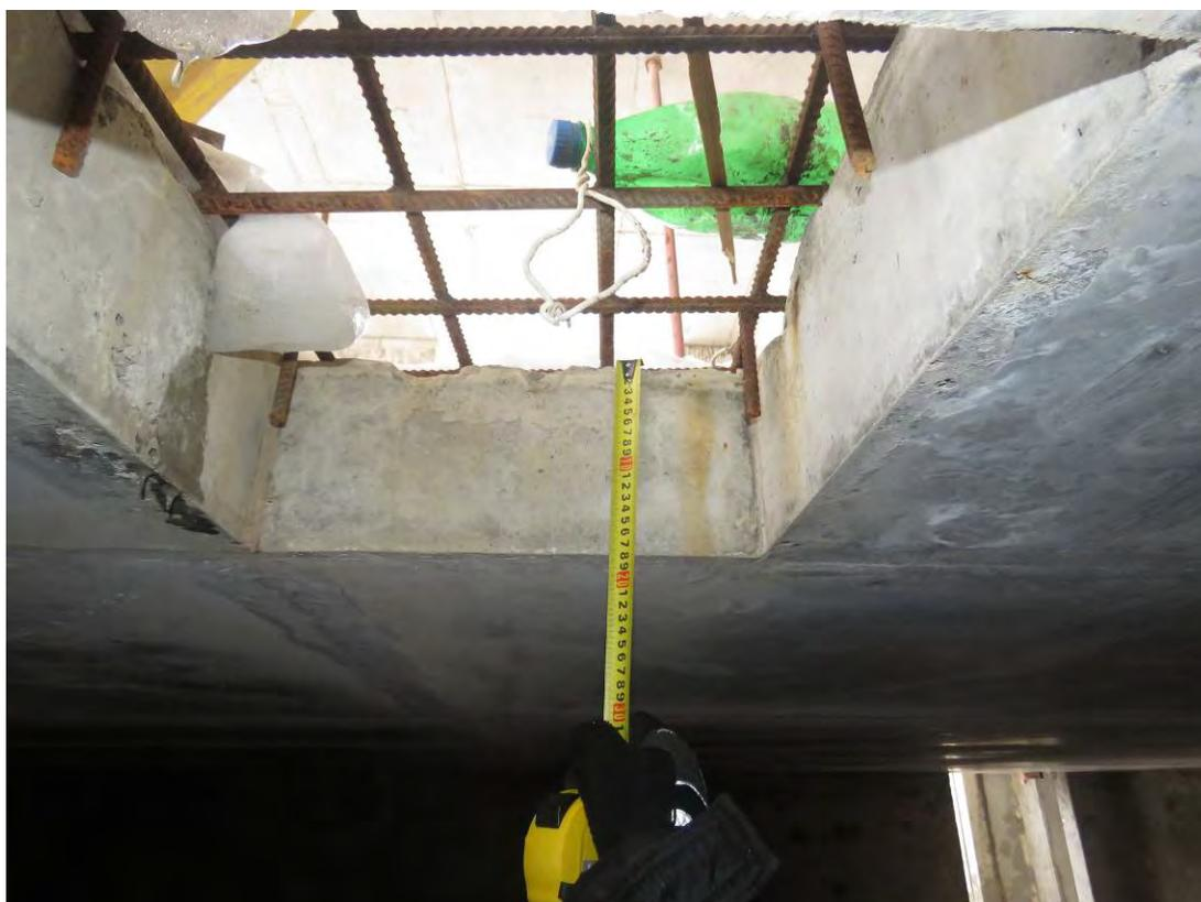
**Рис. 2.2. Замер толщины плиты перекрытия подвального этажа секции №1 при помощи металлической рулетки**
