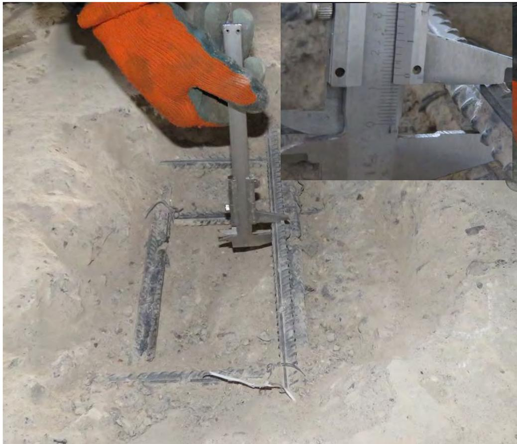
**Рис. 3.1.10. Определение диаметра (14 мм) арматуры верхней зоны армирования фундаментной плиты секции 3 между осями 13с3-14с3, Бс3-Вс3**
