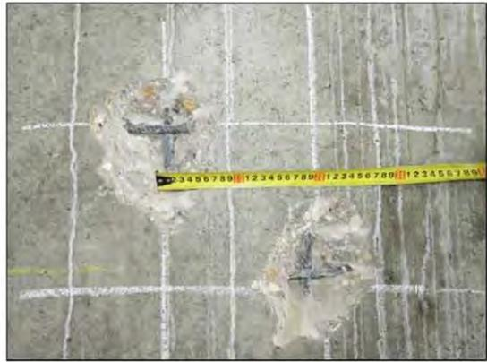
ФОТО 18. Уточнение шага рабочей арматуры монолитного ж/б пилона 1-го этажа расположенного на пересечении осей «Ас3» и «12с3».
