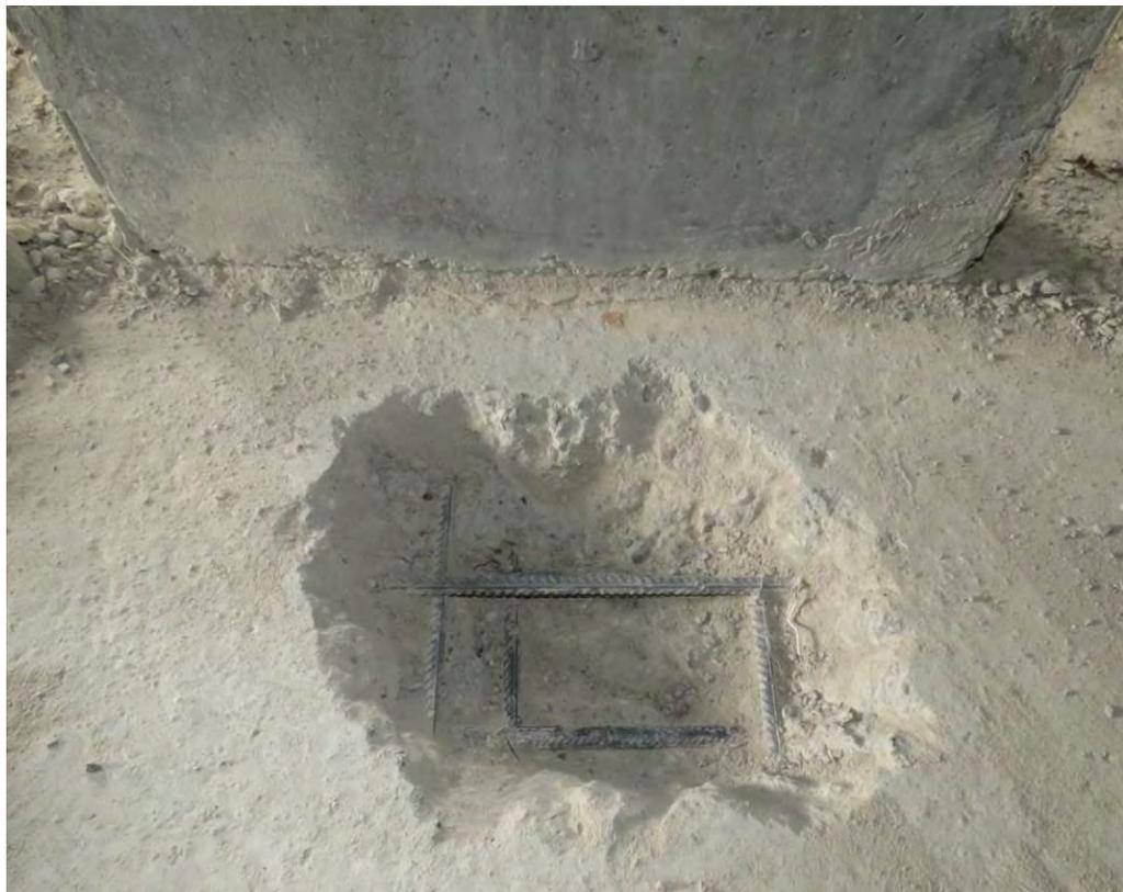
**Рис. 3.1.4. Общий вид вскрытия фундаментной плиты секции 3 по оси 12с3 между осями Вс3-Гс3**
