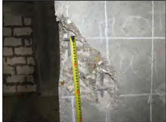
ФОТО 6. Уточнение шага рабочей арматуры монолитного ж/б пилона подвала по оси «Вс4» и «13с3».
