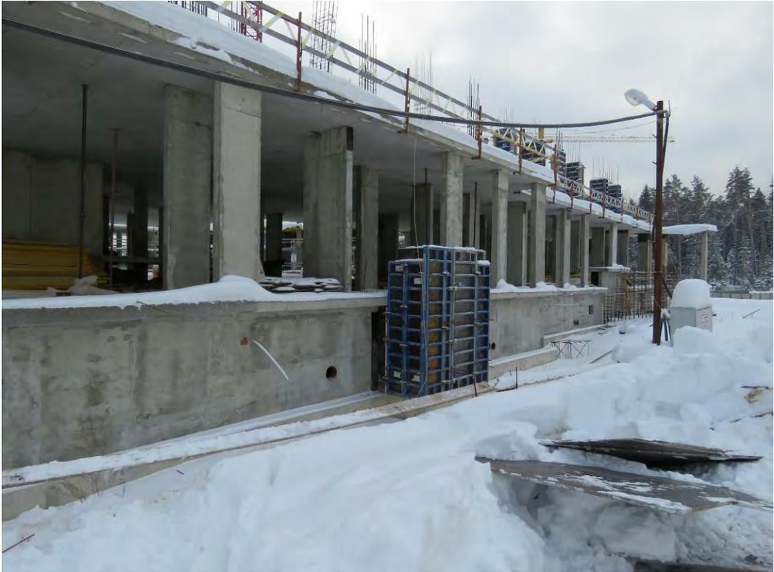
**Рис. 3.1.13 Отсутствие 2-х слоев вертикальной оклеечной гидроизоляции стеклогидроизола типа «ЭПП» и дренажной мембраны типа «Дрениз» на монолитной железобетонной фундаментной плите, наблюдается по всему периметру здания**
