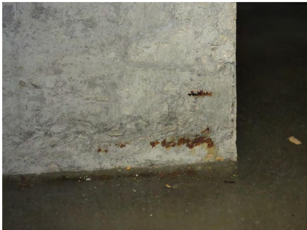
**Рис. 3.2.6. Отсутствие защитного слоя бетона с поражением коррозией арматурных стержней пилона на отм. -3,300 м между осями 8с1-6с1, Вс1-Дс1**
