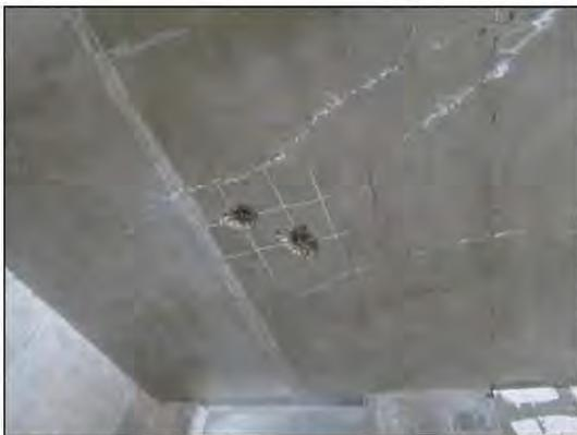
ФОТО 7. Общий вид вскрытия потолочной поверхности монолитной железобетонной плиты перекрытия подвала расположенной между осями «13с3»-«14с3» и «Вс4»-«Гс4».
