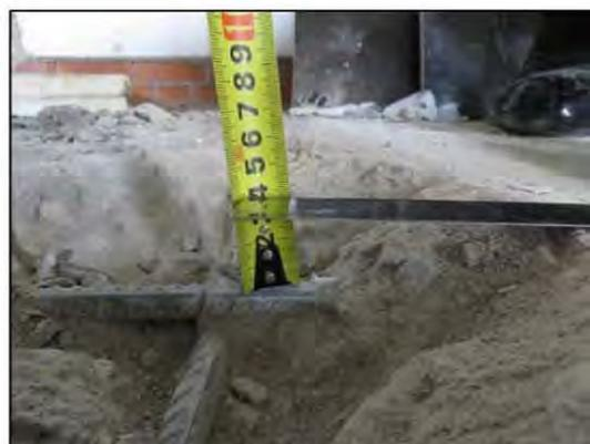
ФОТО 12. Уточнение защитного слоя бетона напольной поверхности фундаментной плиты расположенной между осями «Гс3»-«Гс4» и «Бс3»-«Вс3».
