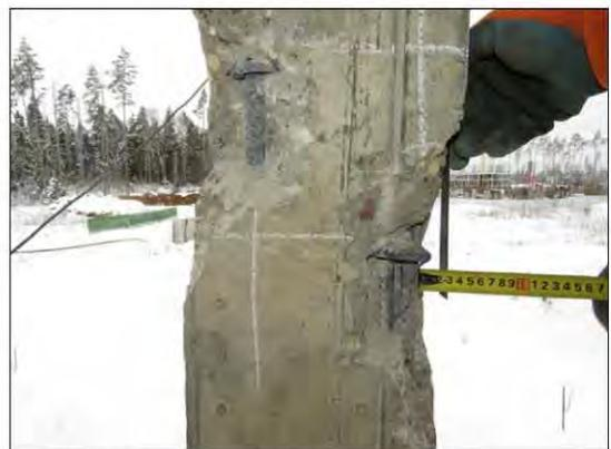
ФОТО 16. Уточнение защитного слоя бетона монолитной ж/б колонны расположенной на пересечении осей «Ес3» и «5с3/1».
