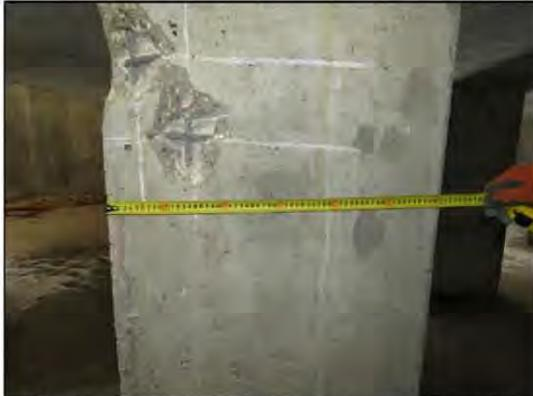
ФОТО 1. Общий вид вскрытия монолитного ж/б пилона подвала по оси «Гс3» между осями «бс3» и «Гс3».
