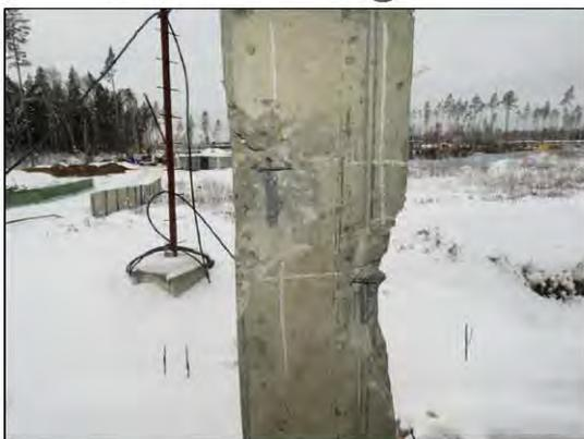
ФОТО 15. Общий вид вскрытия монолитной ж/б колонны расположенной на пересечении осей «Ес3» и «5с3/1».
