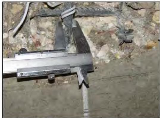
ФОТО 8. Уточнение диаметра рабочей арматуры потолочной поверхности монолитной железобетонной плиты перекрытия подвала расположенной между осями «13с3»-«14с3» и «Вс4»-«Гс4».
