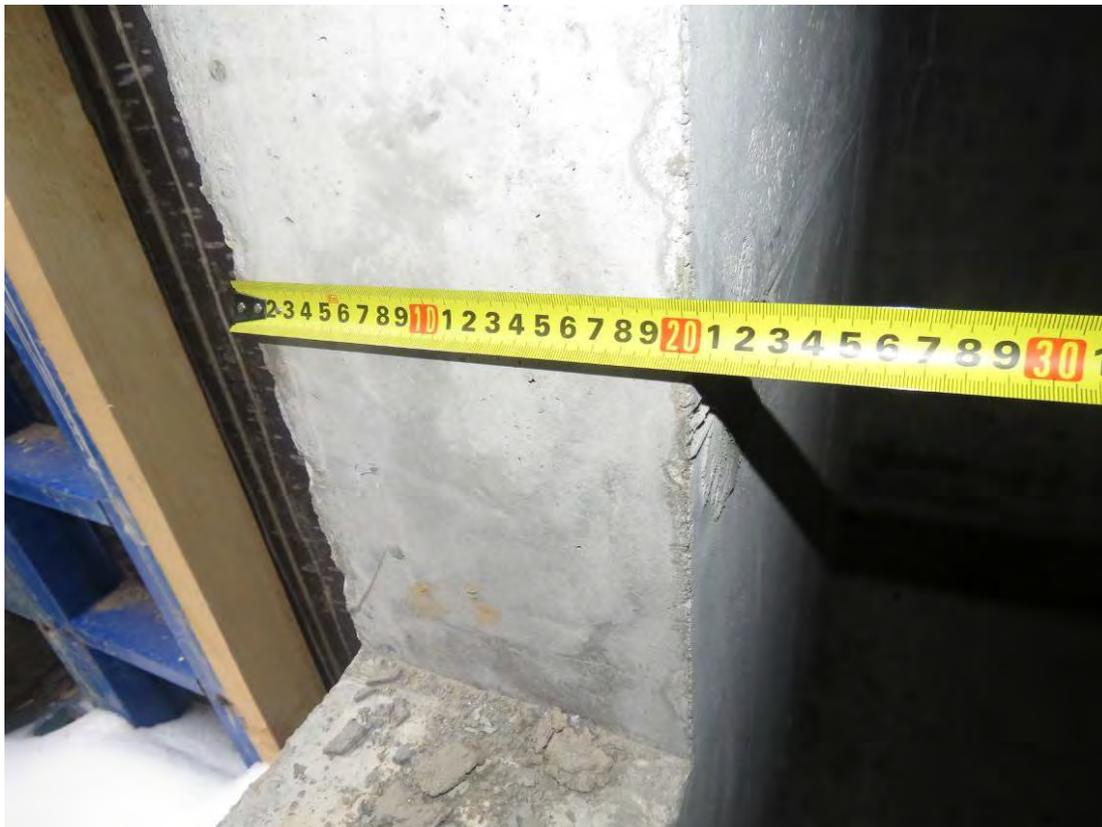
**Рис. 2.1. Замер толщины наружной монолитной ж.б. стены подвального этажа при помощи металлической рулетки**
