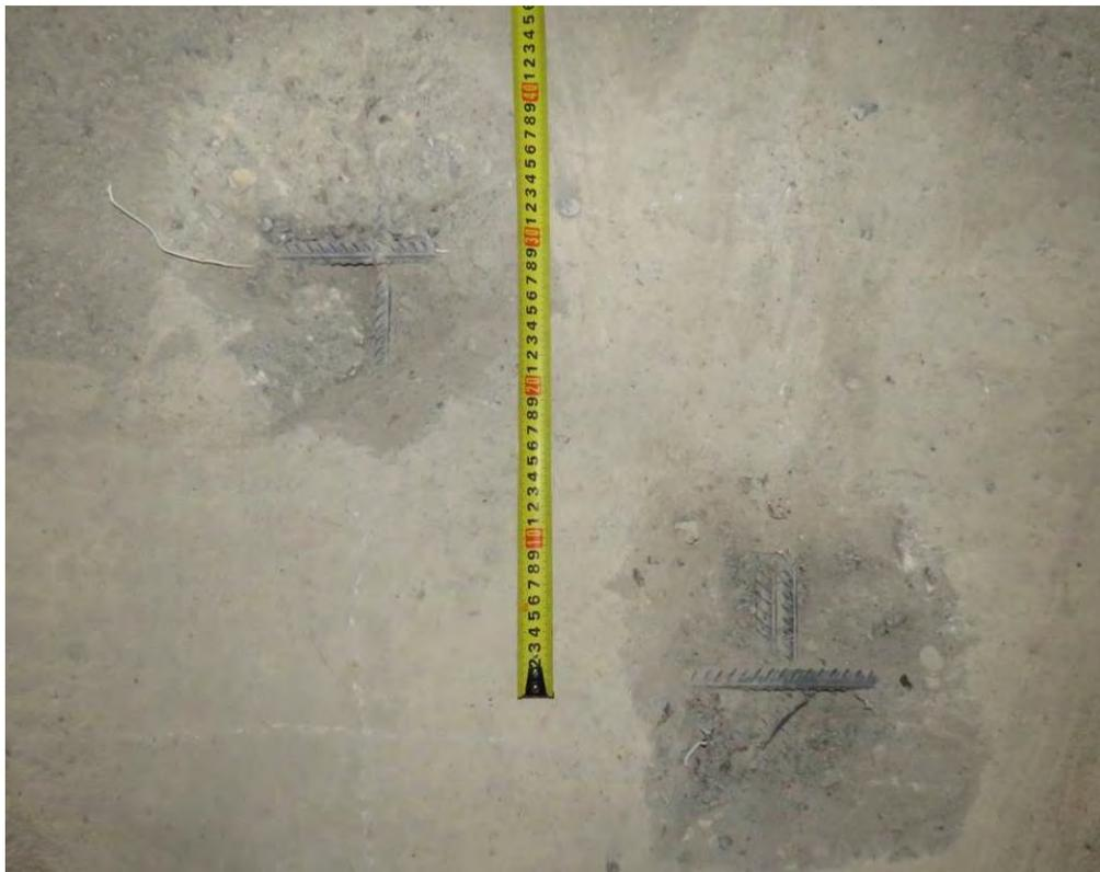
**Рис. 3.1.6. Замер шага (270 мм) вдоль буквенных осей верхней зоны армирования фундаментной плиты секции 3 между осями 13с3-14с3, Бс3-Вс3**
