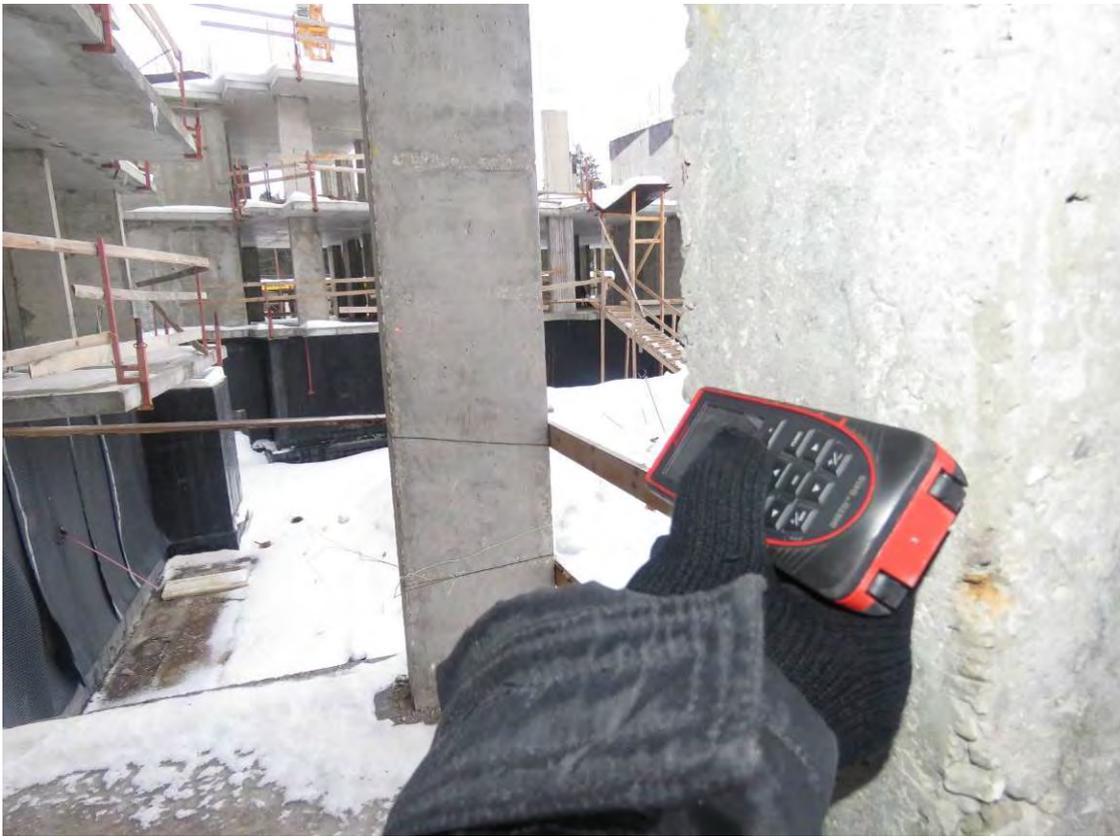
**Рис. 2.3. Замер шага пилонов секции №6 в уровне 1-го этажа по оси Ес6/1 между осями 3с6-4с6 при помощи лазерного дальномера Leica DISTO D410**
