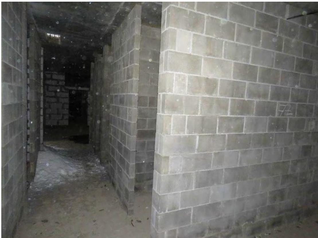
**Рис. 3.5.1. Общий вид ограждающих конструкций внутренних перегородок в подвальном этаже секции №5**
