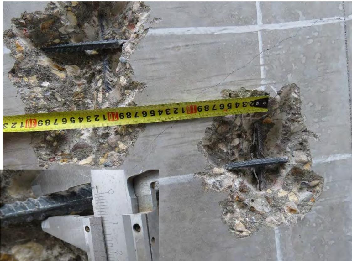
**Рис. 3.3.8. Замер геометрических параметров нижнего армирования плиты перекрытия 1-го этажа между осями Бс3-Вс3 и 2с4-3с4**
