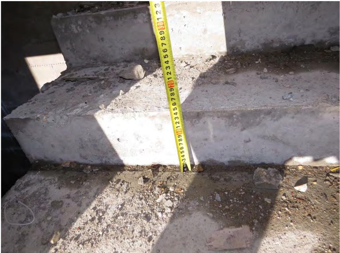
**Рис. 3.5.4. Уточнение высоты подступенка лестничной конструкции расположенной между осями 4с4-5с4 и Бс4Вс3 в секции 4**
