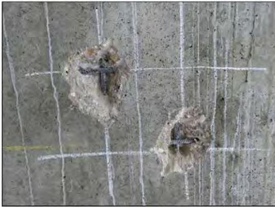
ФОТО 17. Общий вид вскрытия монолитного ж/б пилона 1-го этажа расположенного на пересечении осей «Ас3» и «12с3».
