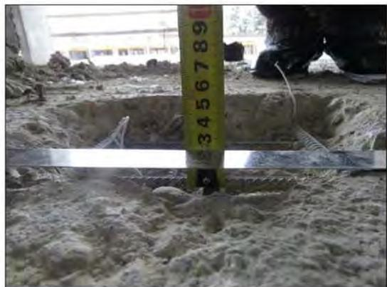
ФОТО 20. Уточнение защитного слоя бетона напольной поверхности монолитной ж/б плиты перекрытия подвала расположенной между осями «Вс3»-«Гс3» и «11с3»-«12с3».
