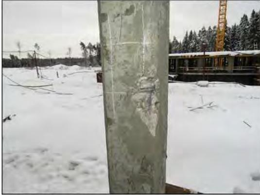
ФОТО 25. Общий вид вскрытия монолитной ж/б колонны 1-го этажа по оси «Ас3/1» и «3с4».
