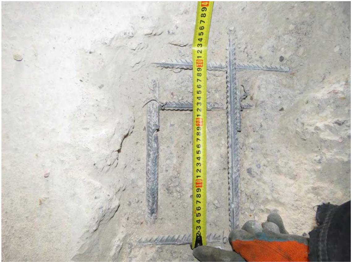
**Рис. 3.1.9. Замер шага (220 мм) вдоль цифровых осей верхней зоны армирования фундаментной плиты секции 3 по оси 12с3 между осями Вс3-Гс3**
