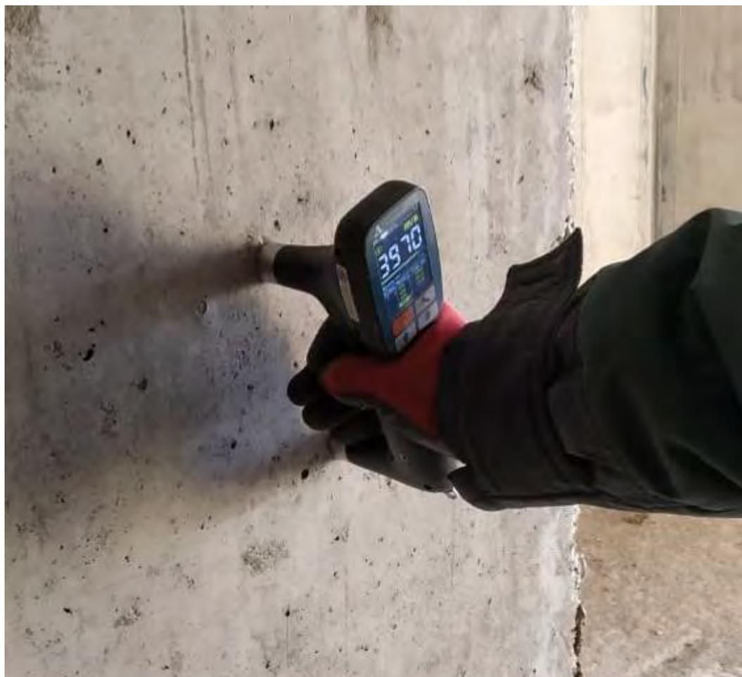
**Рис. 4.3.1. Определение прочности бетона в монолитном железобетонном пилоне ультразвуковым методом прибором UK 1401**
