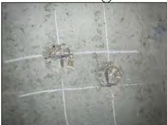
ФОТО 9. Общий вид вскрытия монолитной ж/б стены подвала расположенной по оси «Гс4» между осями «Гс3»-«Гс4».
