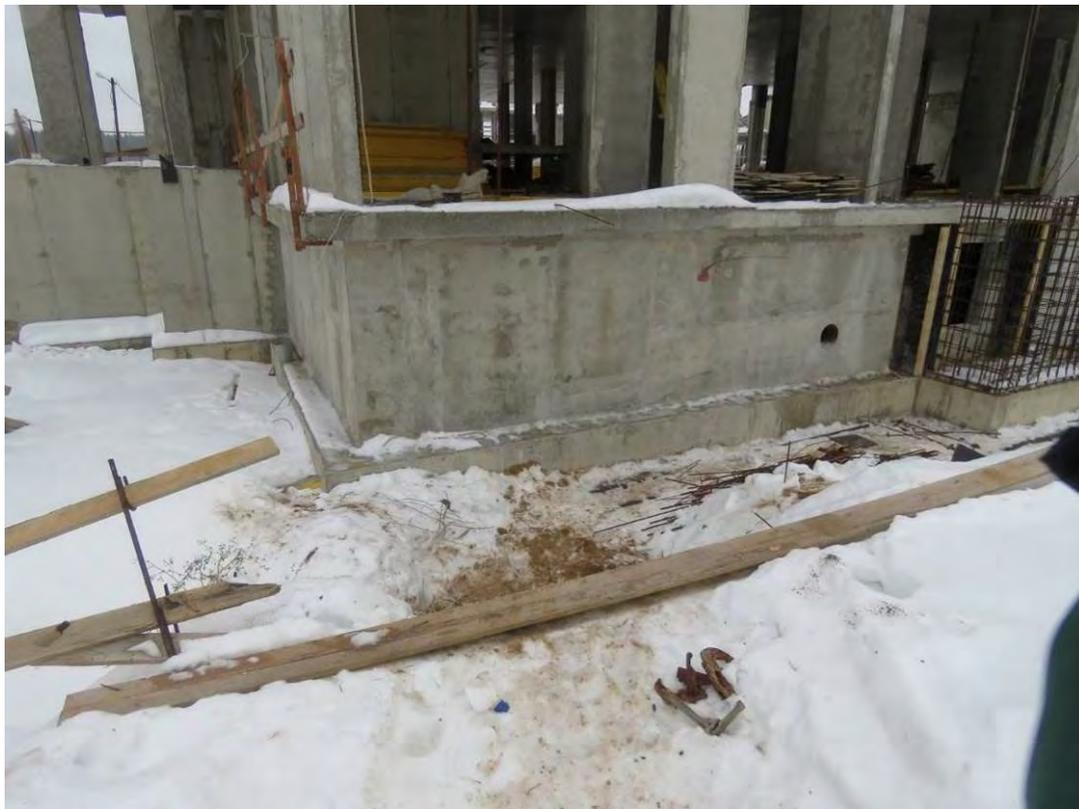
**Рис. 3.1.1. Общий вид фундаментной плиты под наружную несущую монолитную ж.б. стену здания, секция 1 между осями Жс1 – Лс1**
