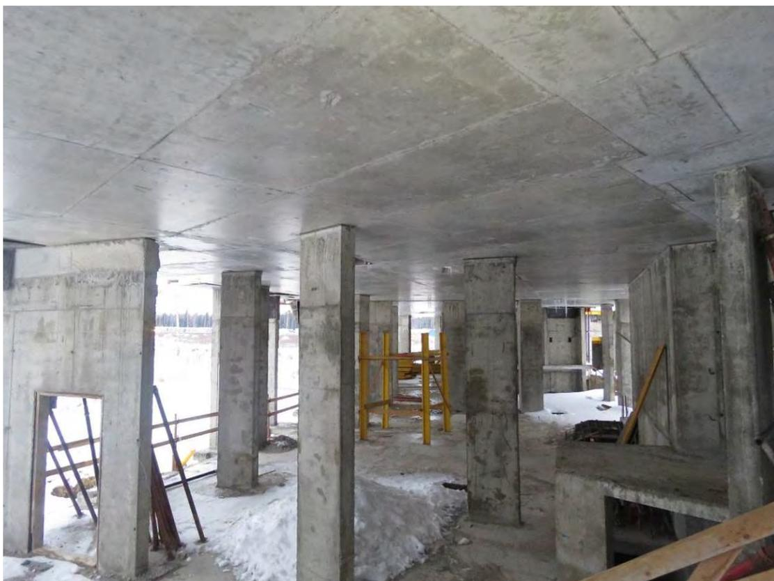
**Рис. 3.3.2. Общий вид монолитной ж.б. плиты покрытия 1-го этажа**
