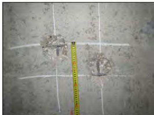
ФОТО 10. Уточнение шага рабочей арматуры монолитной ж/б стены подвала расположенной по оси «Гс4» между осями «Гс3»-«Гс4».
