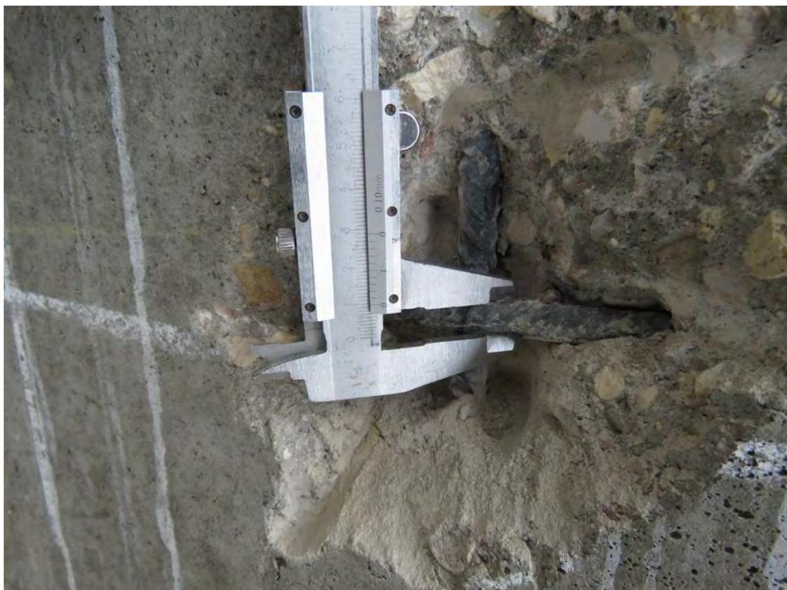
**Рис. 3.2.2. Замер диаметра горизонтального армирования стены на отм.  $-3,300$  м по оси В/4 между осями 3/4-4/4**
