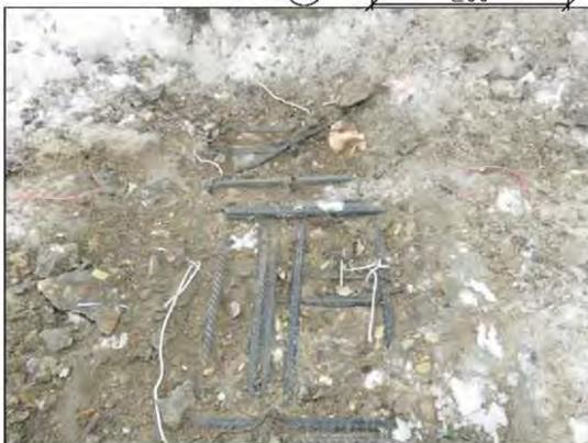
ФОТО 27. Общий вид вскрытия напольной поверхности плиты перекрытия 1-го этажа расположенной между осями «2с4»-«3с4» и «Вс4»-«Гс4».
