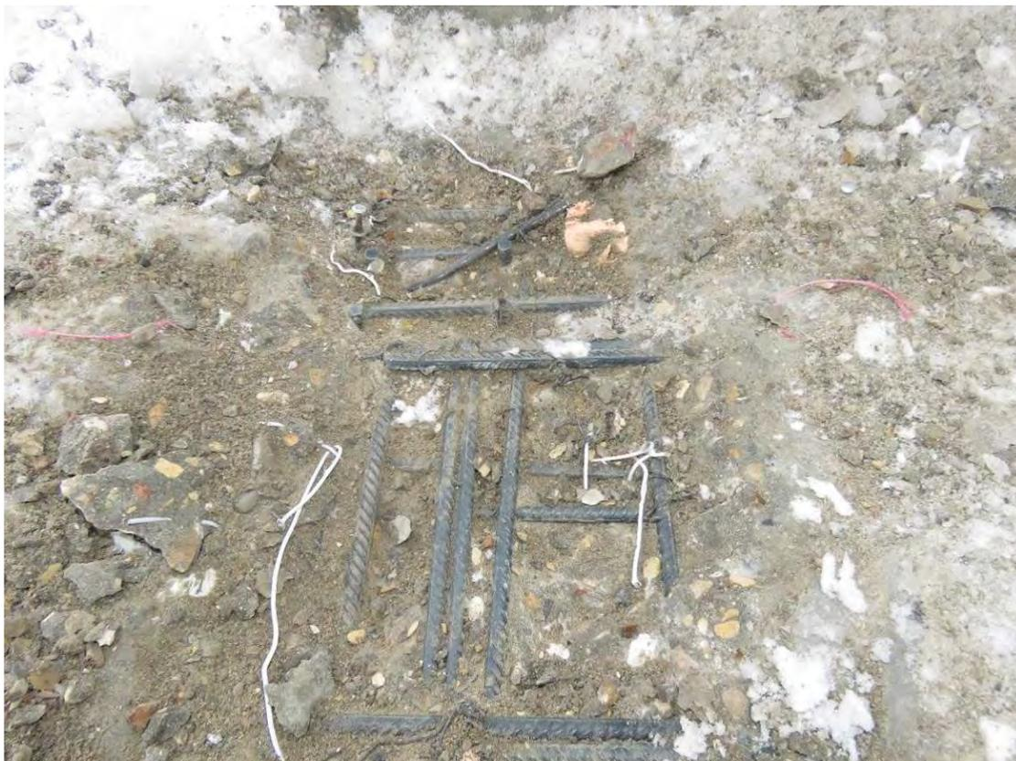
**Рис. 3.3.9. Общий вид участка вскрытия верхней зоны монолитной ж.б. плиты перекрытия 1-го этажа (в зоне пилона на пересечении осей Ас3 и 2с4)**
