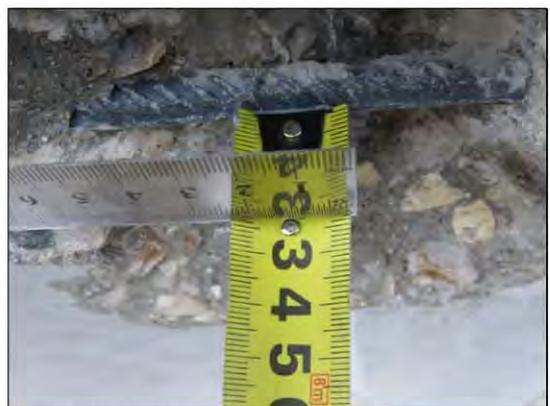
ФОТО 24. Уточнение защитного слоя бетона потолочной поверхности плиты перекрытия 1-го этажа расположенной между осями «Bc3»-«Bc3» и «Bc4»-«Гс4».
