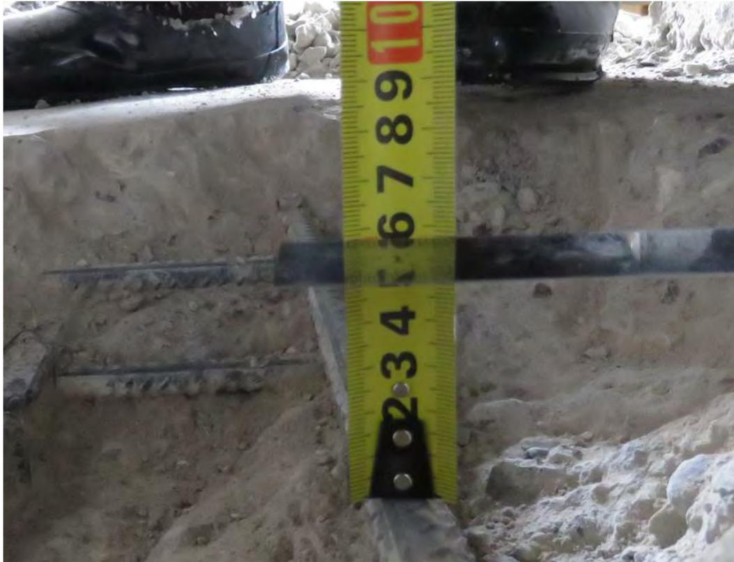
**Рис. 3.1.11. Определение толщины (58 мм) защитного слоя бетона верхнего армирования фундаментной плиты секции 3 по оси 12с3 между осями Вс3-Гс3**
