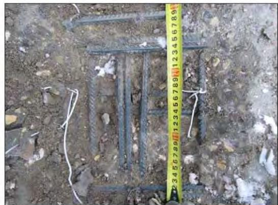
ФОТО 28. Уточнение шага рабочей арматуры напольной поверхности плиты перекрытия 1-го этажа расположенной между осями «2с4»-«3с4» и «Вс4»-«Гс4».
