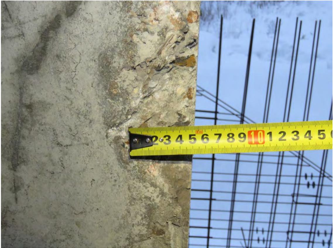
**Рис. 3.2.7. Скол бетона монолитной ж.б. колонны между осями 7с2- 8с2, на отм. +3,000 м секции 3**
