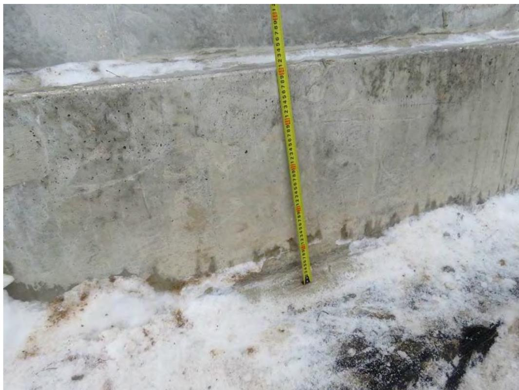
**Рис. 3.1.2. Замер толщины фундаментной плиты в месте отсутствия обратной засыпки, секция 1 между осями Жс1 – Лс1**
