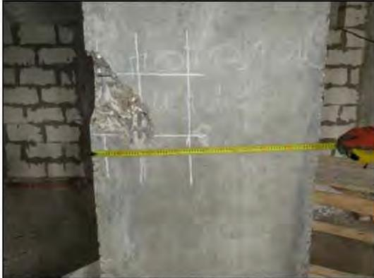
ФОТО 5. Общий вид вскрытия монолитного ж/б пилона подвала по оси «Вс4» и «13с3».
