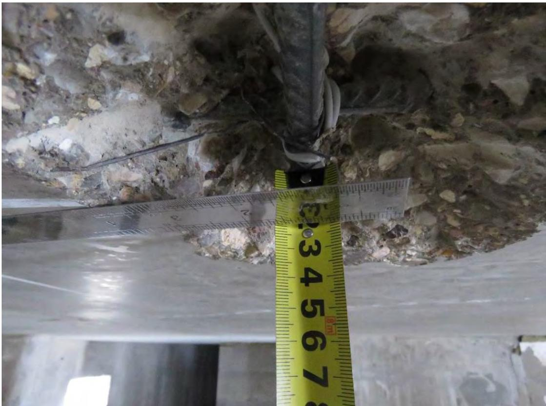
**Рис. 3.3.6. Замер толщины защитного слоя бетона нижнего армирования монолитной ж.б. плиты перекрытия подвала между осями Vc4-Дс3 и 13с3-14с3**
